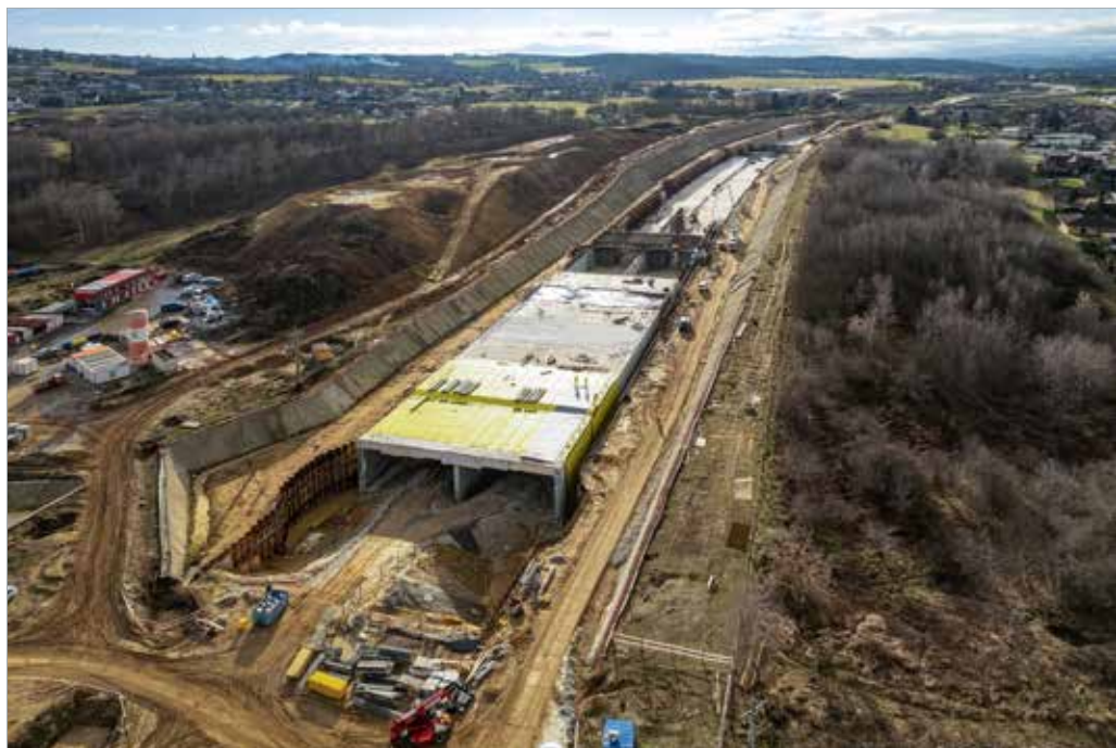
Vznikající železobetonová konstrukce tunelu v zapažené stavební jámě, staveniště střed
