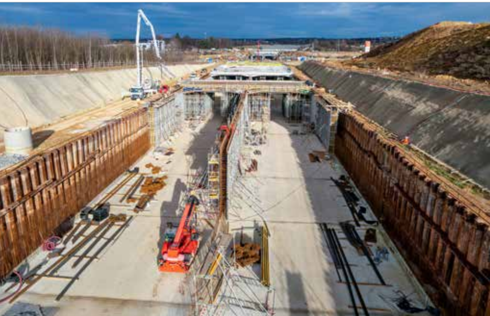
Proudová metoda výstavby železobetonové konstrukce tunelu ve stavební jámě pažené kotvenými štětovými stěnami, staveniště střed
