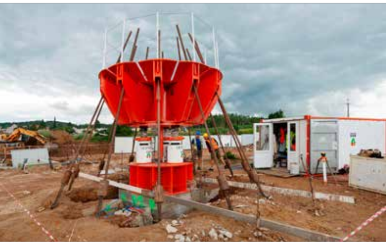
Zatěžovací zkouška ocelovým mostem typu „hříbek“ s únosností 15 MN pro stanovení plášťového tření podzemních stěn
