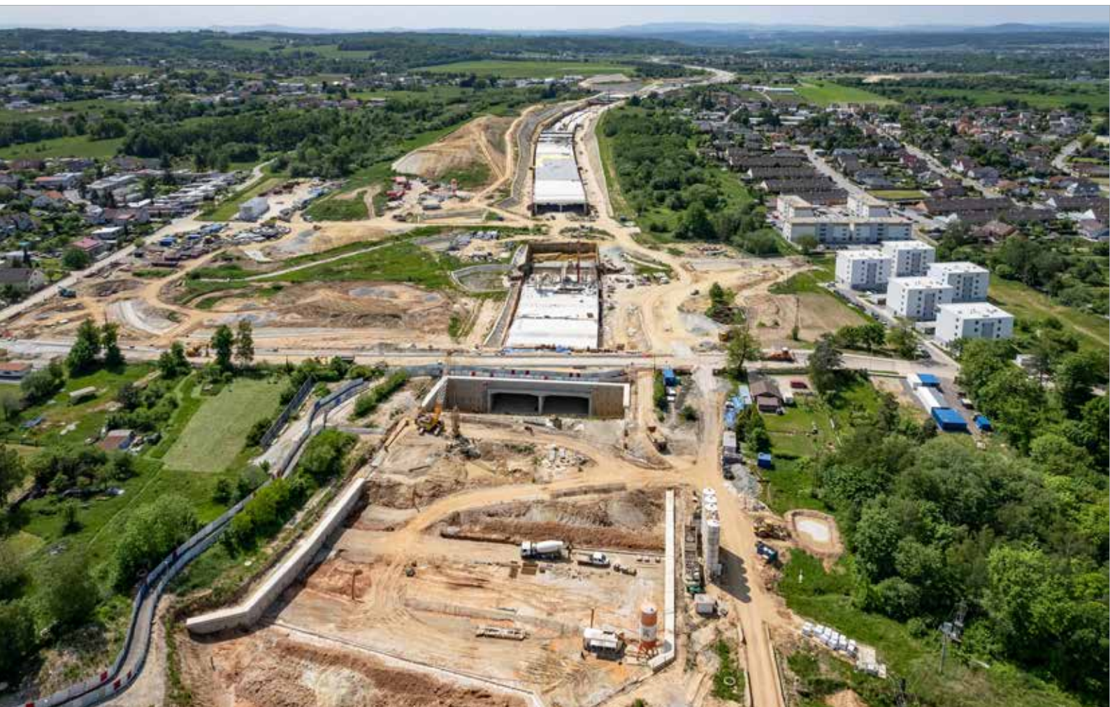
Pohled na staveniště v místě Pražského portálu s přecházející Dobrovodskou ulicí
