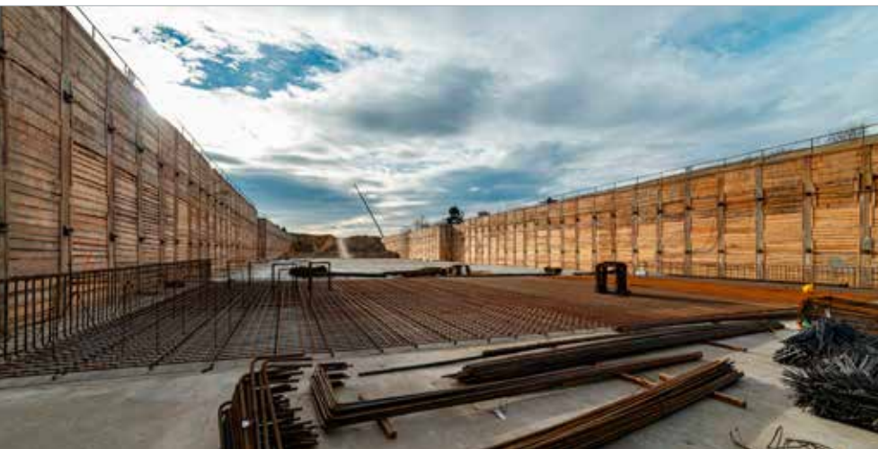
Armování základové desky tunelu
