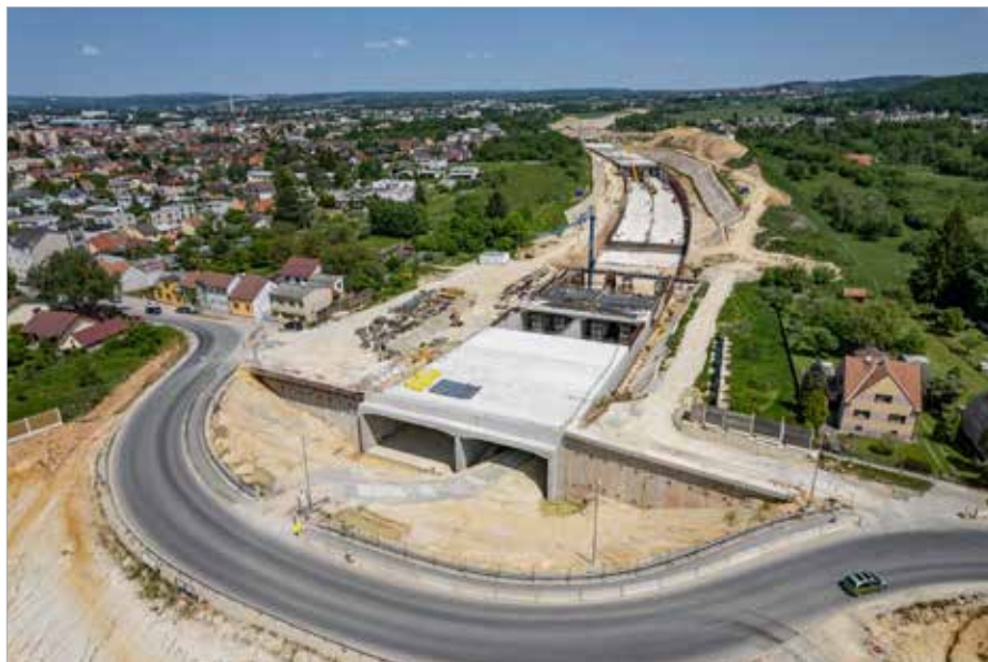
Pažení stavební jámy Kaplického portálu podzemními stěnami s dokončovanou hrubou vestavbou tunelu
