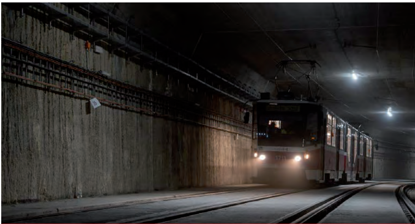
Zkušební jízda tramvaje tunelem.
