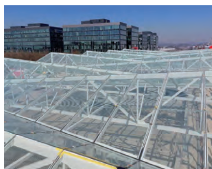
Zastřešení podzemní zastávky Západní brána, pohled k severu.
