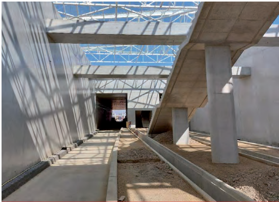
Zastávka Západní brána, pohled z nástupiště severním směrem.
