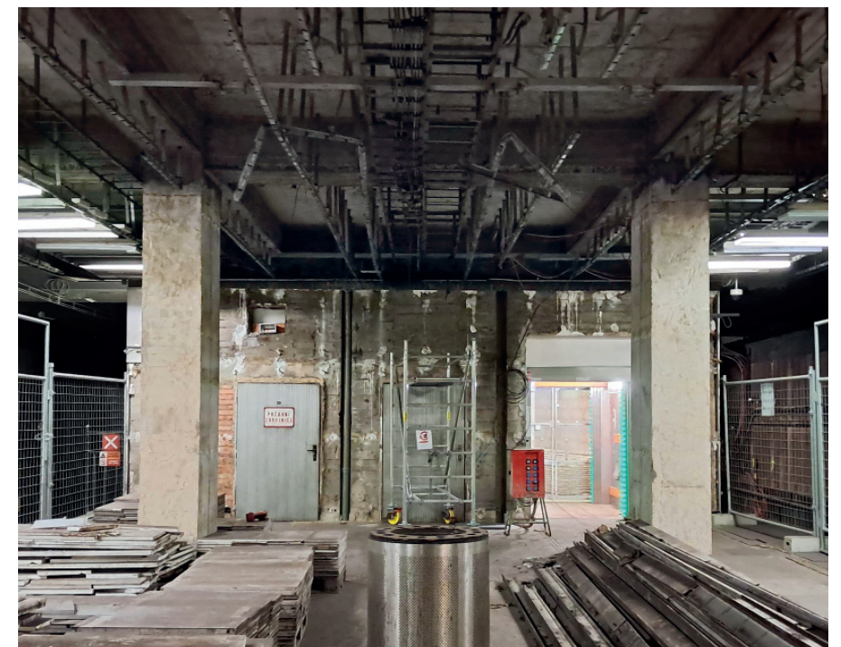
Obr. 8 Původní stav technického zázemí stanice Pankrác C v úrovni nástupiště. Za dveřmi na konci úzké chodby uprostřed fotografie se nachází veřejný prostor nástupiště. Sloup vpravo bylo nutné (po provedení trvalých statických opatření) odstranit.
