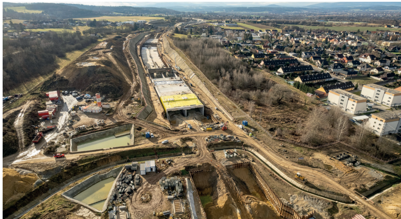
Rozestavěný tunel - leden 2023 (zdroj: archiv Zakládání staveb, a.s.)
