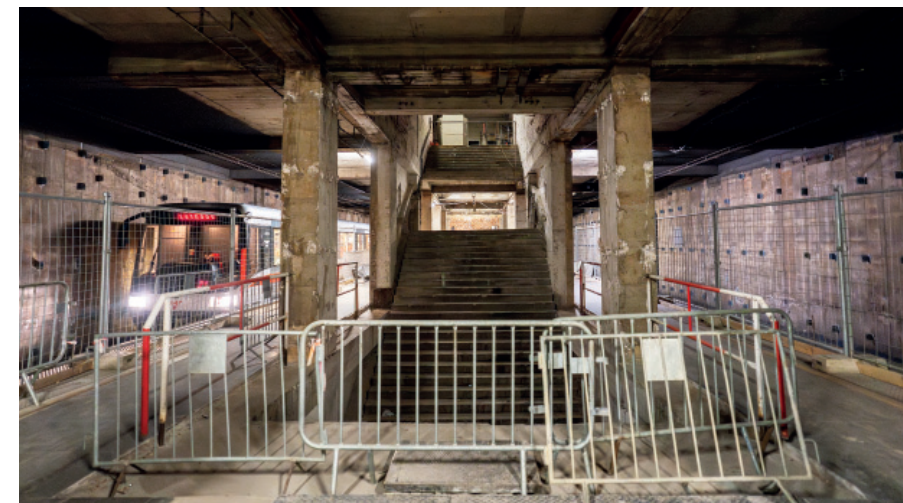
Obr. 15 Prostor dvojice pohyblivých schodů po demontáži opláštění a provedení bouracích prací – stav 03/2025.
