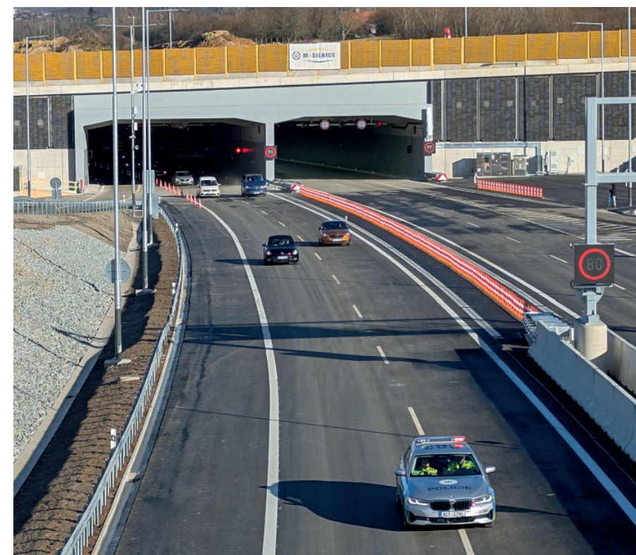
Uvedení do provozu - policejní vůz vyjíždí z tunelu (Kaplický portál)
