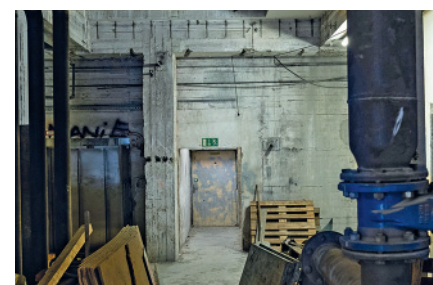
Obr. 9 Stav po odstranění sloupu - stav 03/2025.
