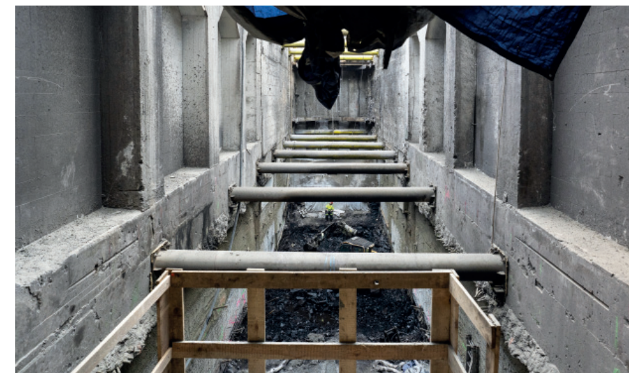
Obr. 4 V tomto prostoru, mezi dvěma traťovými tunely, bude procházet hloubená část eskalátorového tunelu pro přestup mezi trasami C a D – stav 03/2025.
