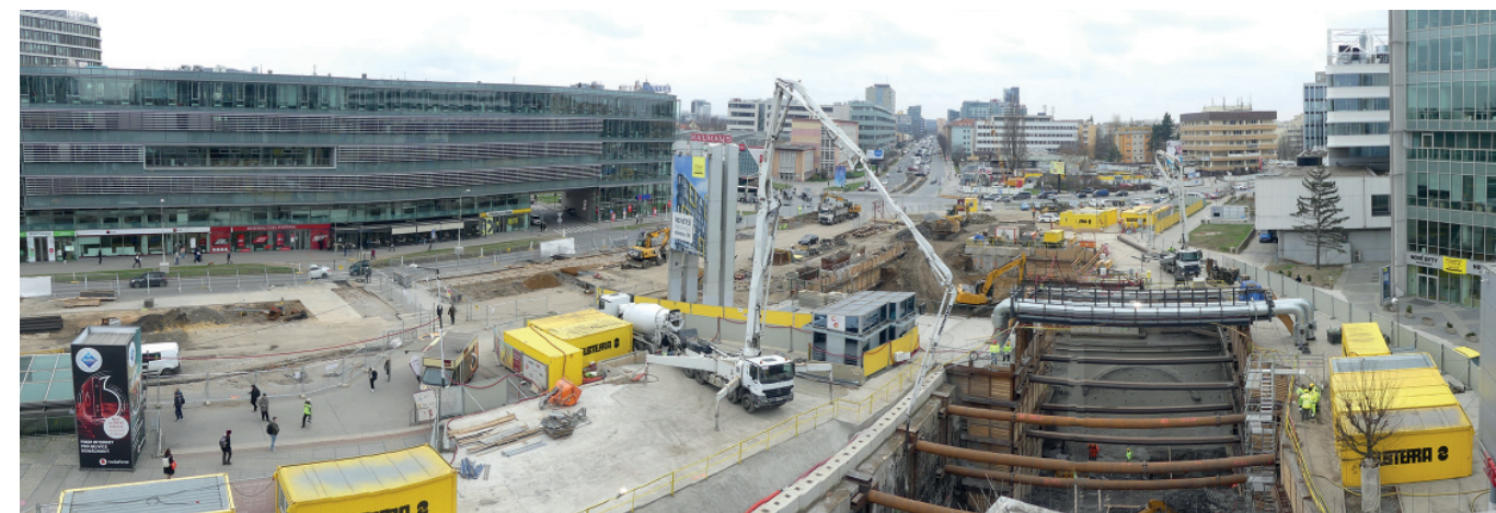
Obr. 2 Výstavba hloubených objektů vestibulu Arkády (jáma vpravo) a přestupního objektu mezi trasami metra C / D (vzdálenější jáma), pohled jižním směrem
