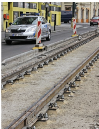
◀ Smetanovo nábřeží, systém W-tram před betonáží desky
