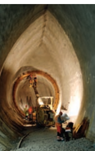
▲ Stanice Petřiny – boční výrub se startovací komorou
