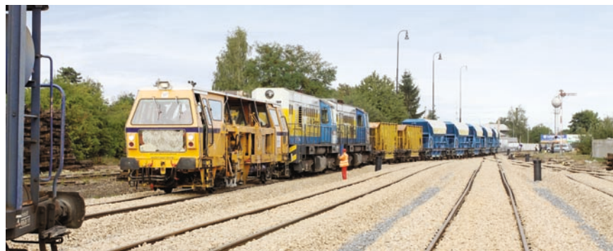
◀ Stanice Rudná. Pracovní vlak na rekonstruovaných kolejích
