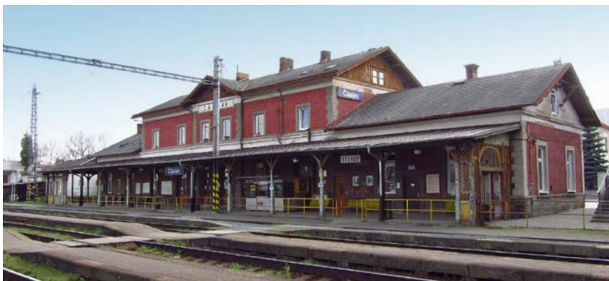
► Železniční stanice Čáslav
