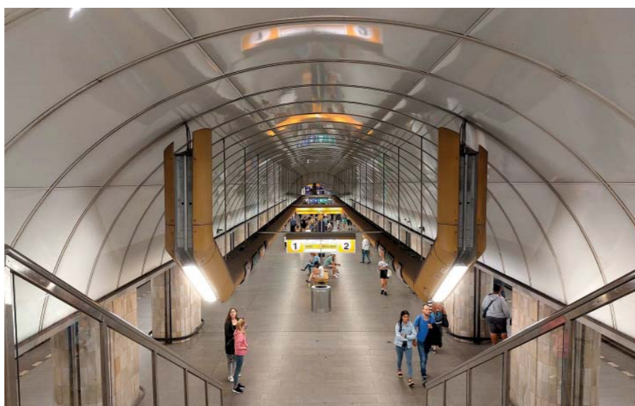
Trasa I.B - stanice Můstek - přestupní ražená sloupová stanice se střední rozšířenou lodí. Architekt: Jarmil Srpa, Miroslav Suchý.
