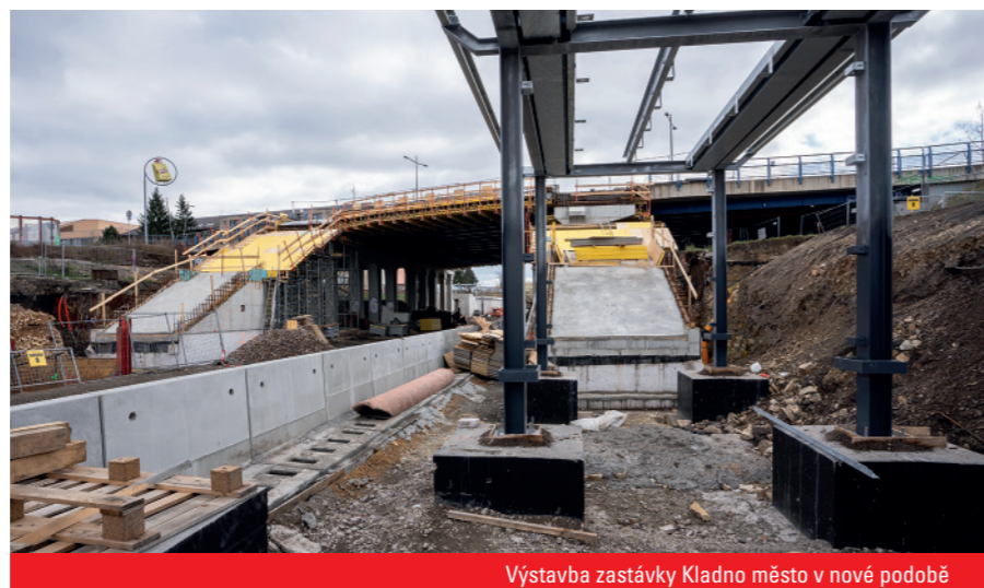
Výstavba zastávky Kladno město v nové podobě
