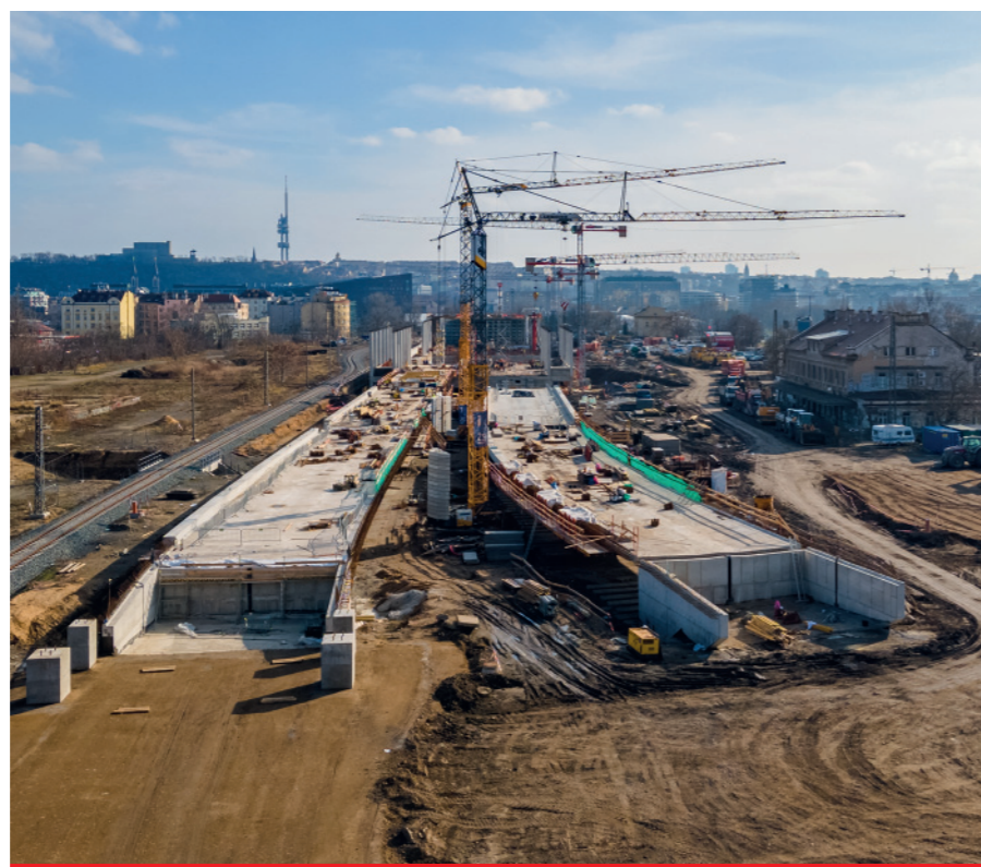
Estakády km 0,450 a km 412,120, vlevo provizorní kolej, vpravo stávající výpravní budova
