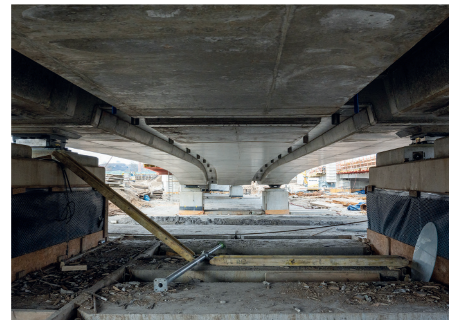
Výstavba estakády, pole nosné konstrukce po odbednění
