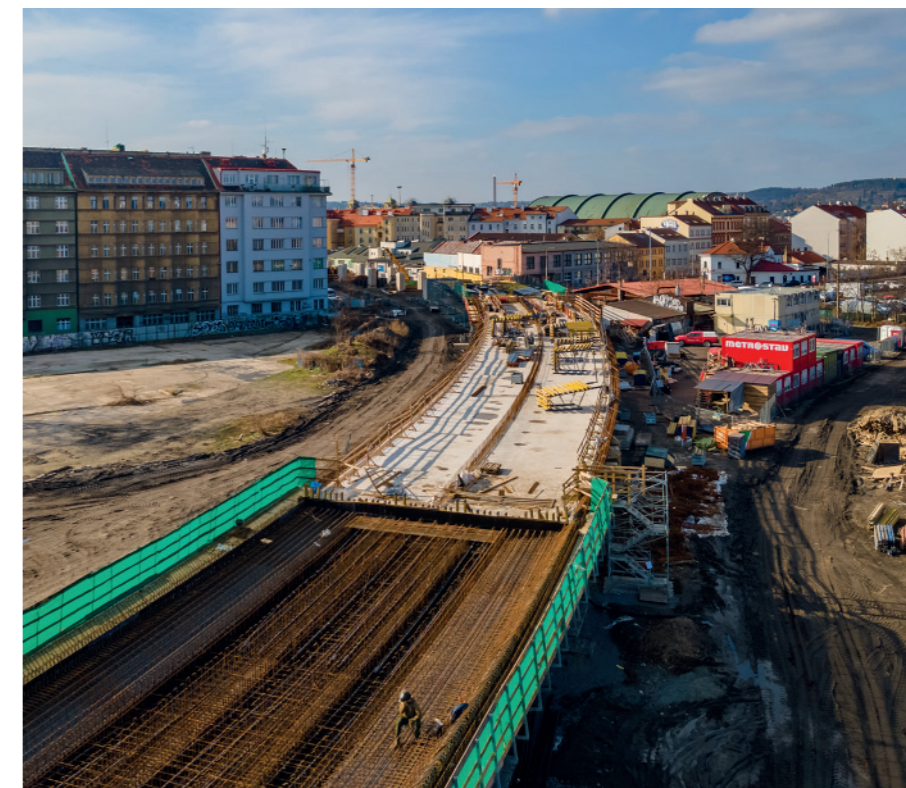
Výstavba estakády směr Výstaviště
