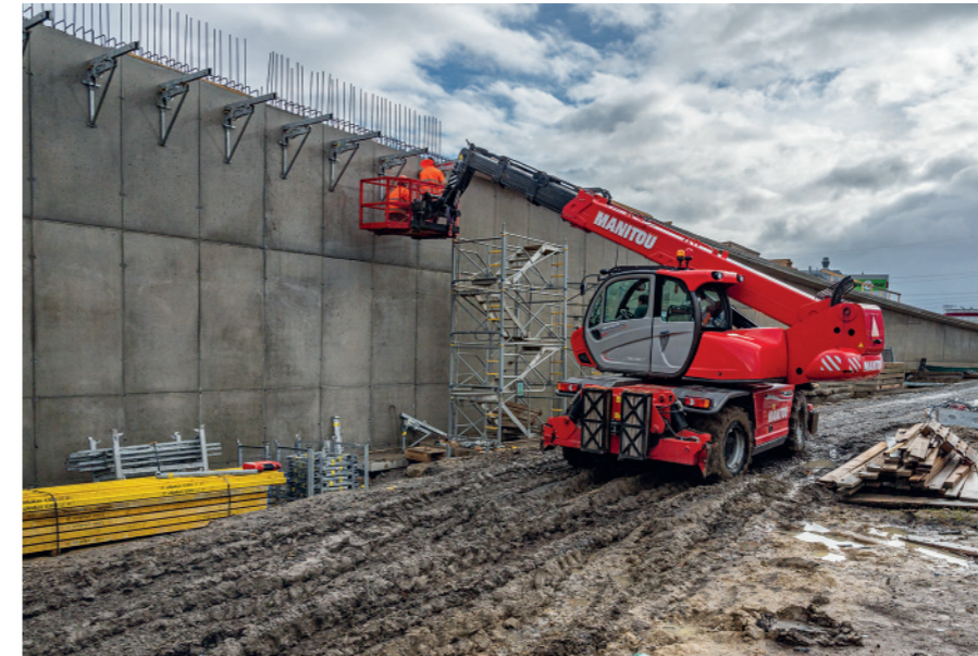
Opěrná zeď v areálu posklizňové linky
