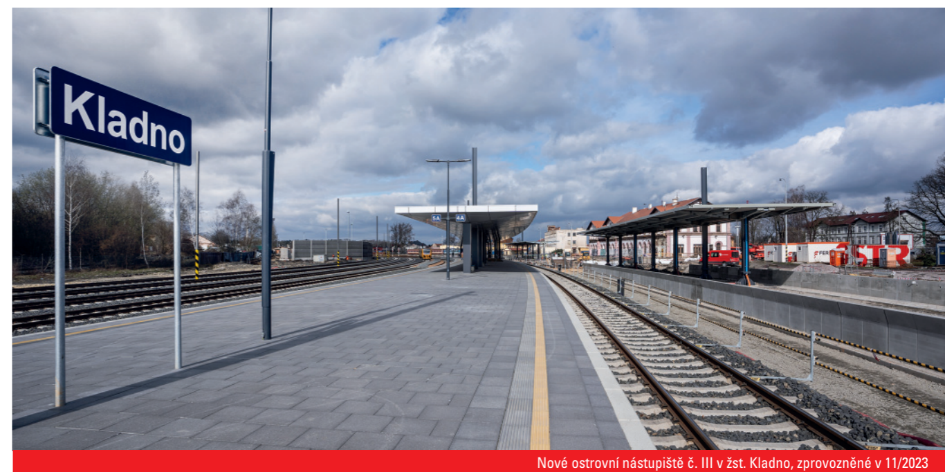
Výstavba žst. Kladno
