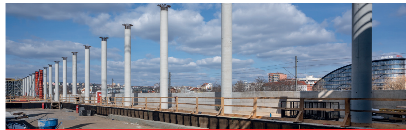
ŽST Praha - Bubny, výstavba nosné konstrukce
